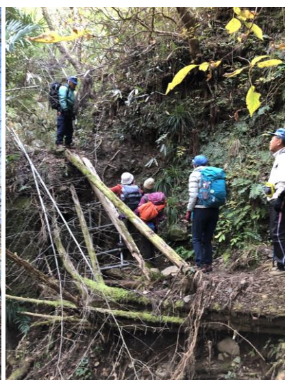
倒木、土砂崩れ箇所
