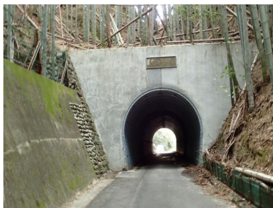
石佛隧道(昭和 27 年竣工)
